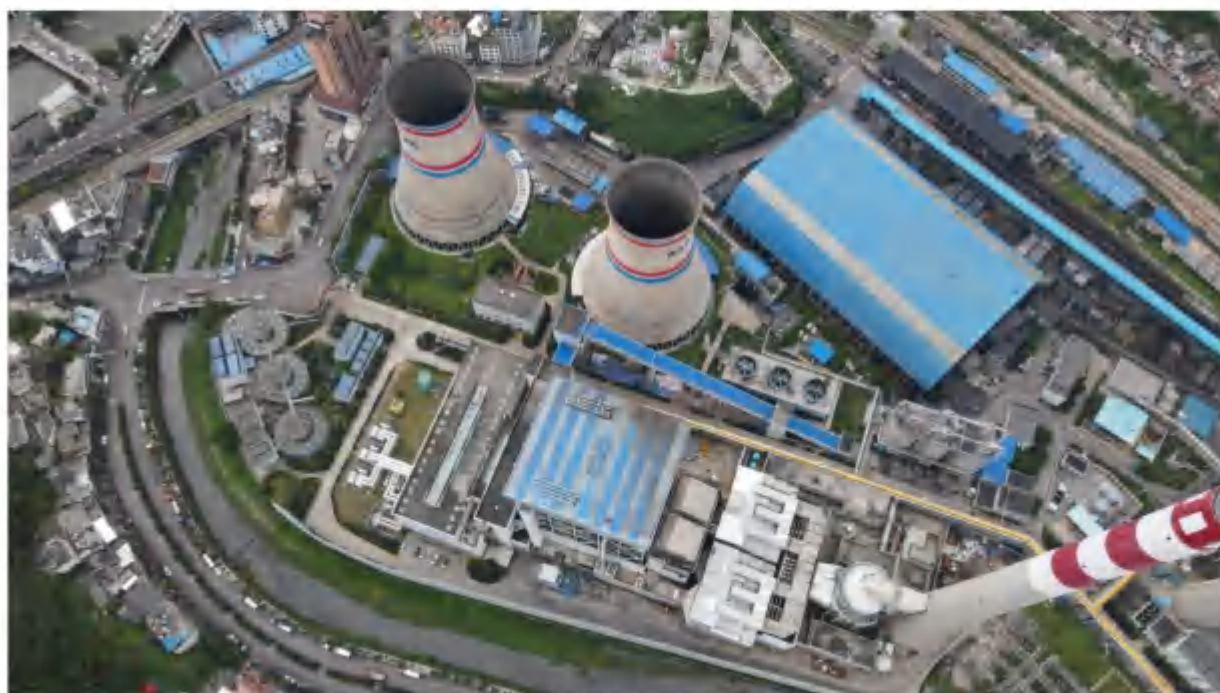
1#主变区域无人机照片
