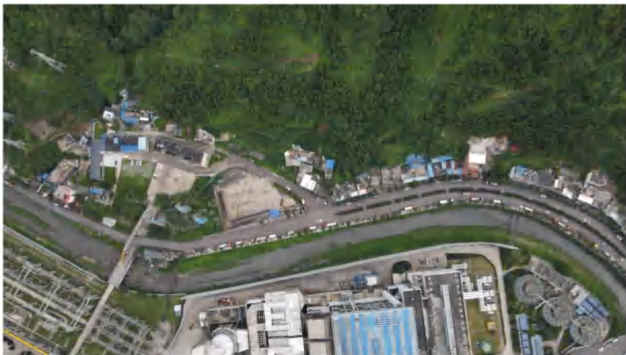
电厂外南侧付家坎东风村区域现状
