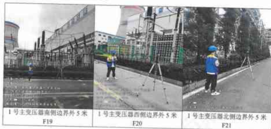
附图 2：现场检测、采样照片
