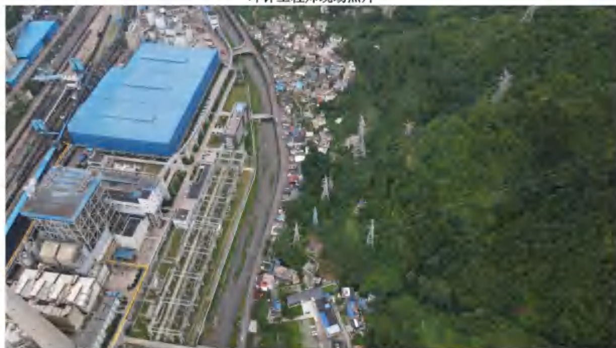
变电站区域无人机照片
