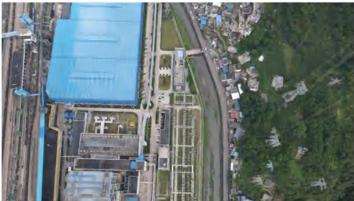
2#主变区域无人机照片
