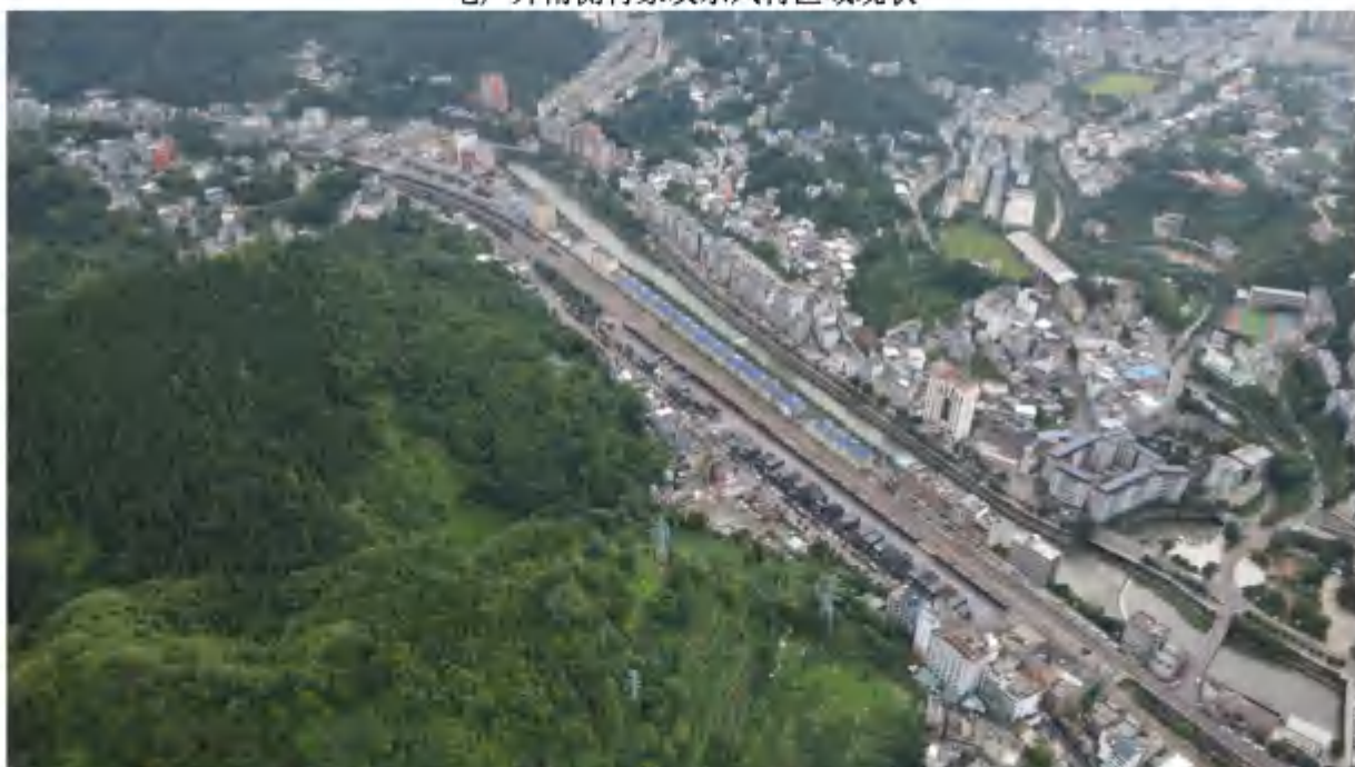
电厂外北侧三家寨区域现状
