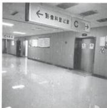
图1 候诊区座椅已拆除
