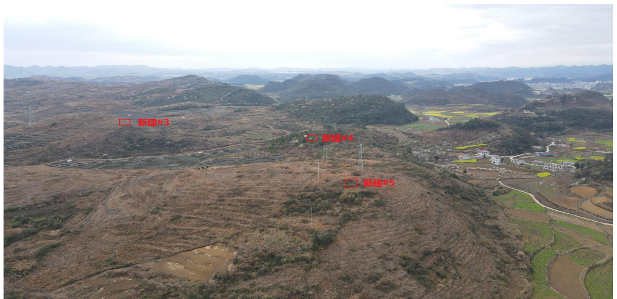
220kV 镇牵线#38~#39 段迁改工程（拍摄于 2025 年 7 月 11 日）
