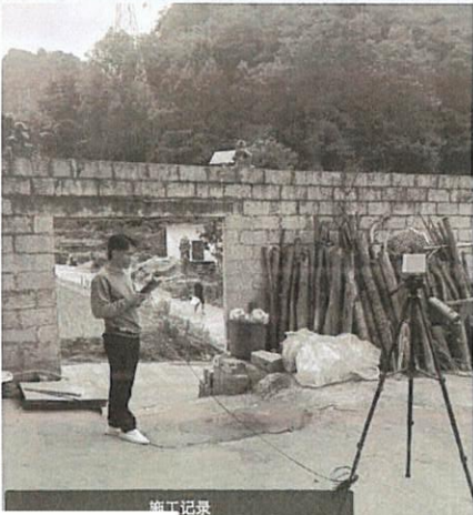
施工记录 地址: 黔南布依族苗族自治州平塘县在丰朝附近 工程名称: 平塘县双桥卓光伏电站220KV线路输出工程环 境影响项目 时间: 2025-06-12 14:41:43
