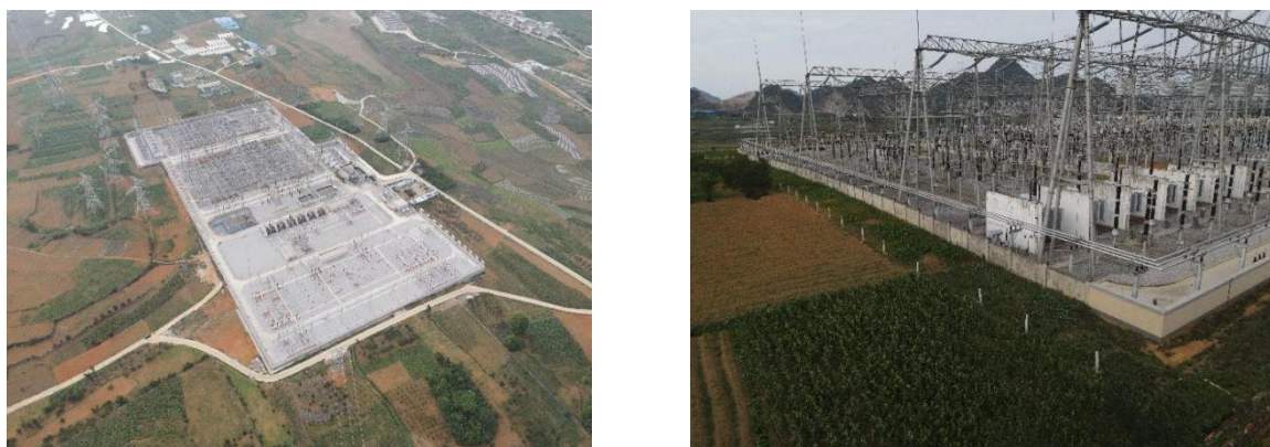
图 4-3 八河 500kV 变电站站址现状照片
