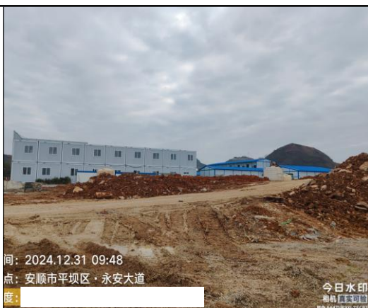
拟建 D01 变电站站址现状
