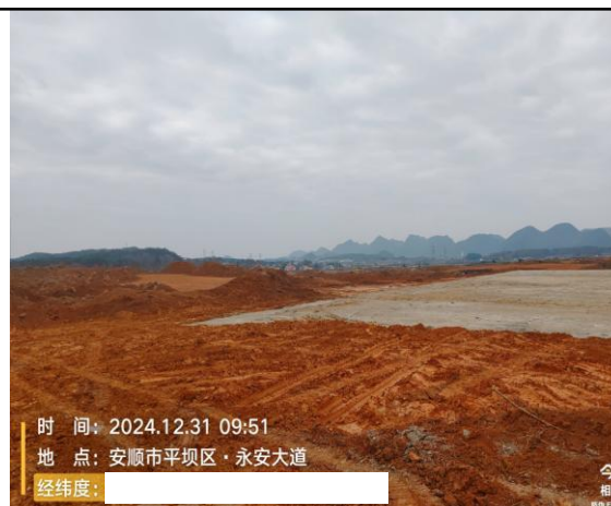
拟建 D02 变电站站址现状
