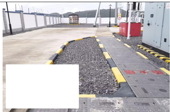
在建将军山 220kV 升压站现状
