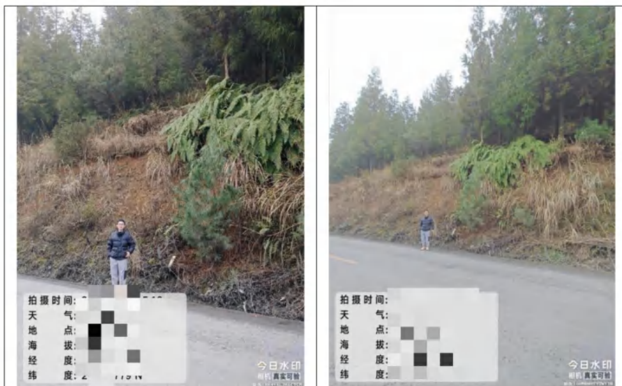
工程师现场踏勘照片
