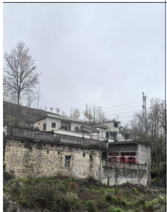
烂坝组 24 号居民住宅
