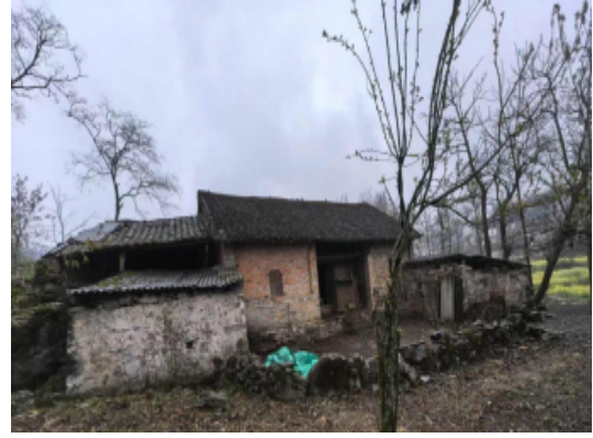
烂坝组 47 号居民住宅
