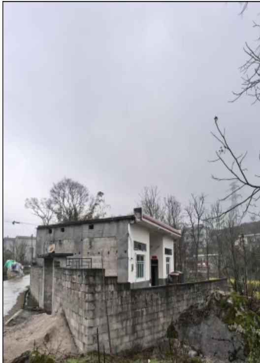
烂坝组 46 号居民住宅
