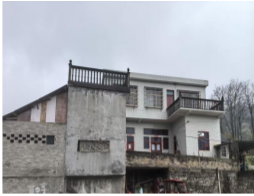
烂坝组 48 号居民住宅
