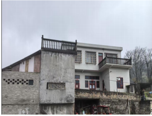
烂坝组 48 号居民住宅
