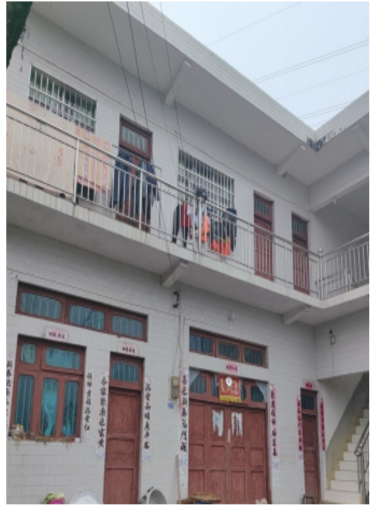
烂坝组 1 号居民住宅
