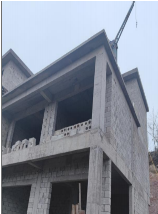
烂坝组 2 号居民住宅
