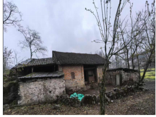
烂坝组 47 号居民住宅
