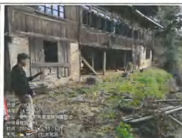
T2、Z2 现场监测照片
