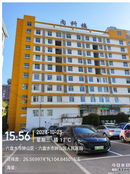
(2) 医院内科大楼
