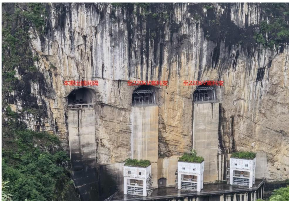
图 2 索风营电厂 220kV 侧出线示意图
