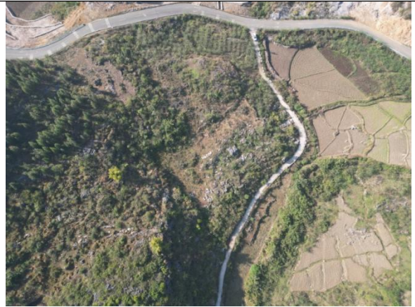
升压站站址航拍图
