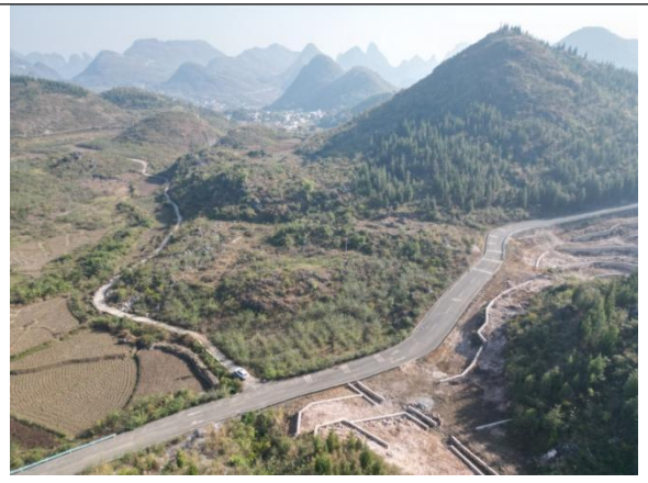
升压站周边环境现状
