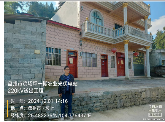
工程师现场踏勘照片
