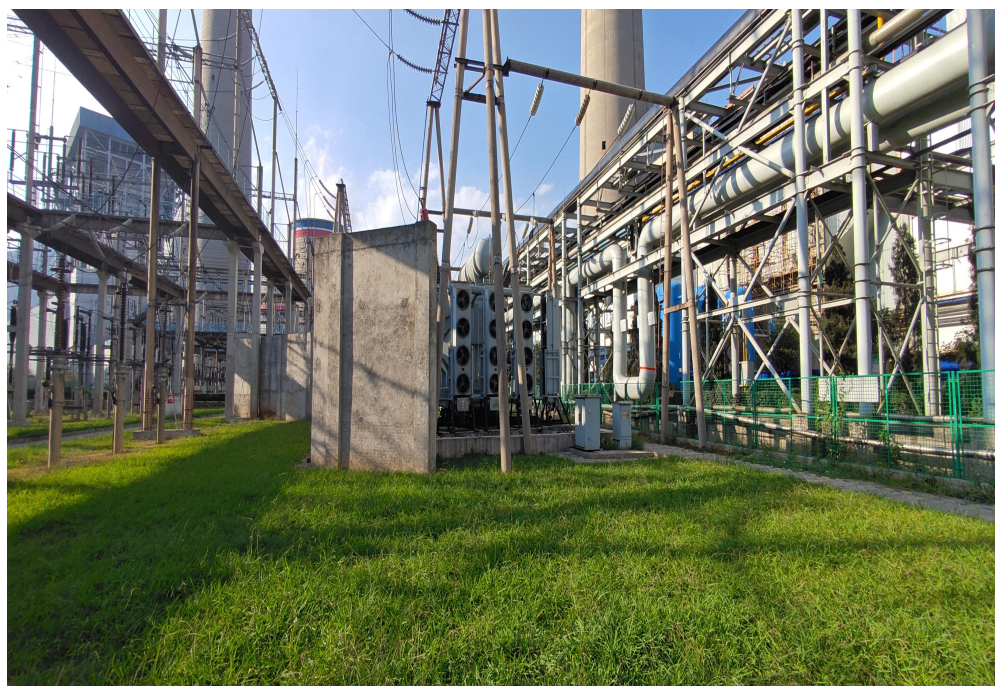
图 4-2 施工临时设施拆除恢复现状照片
