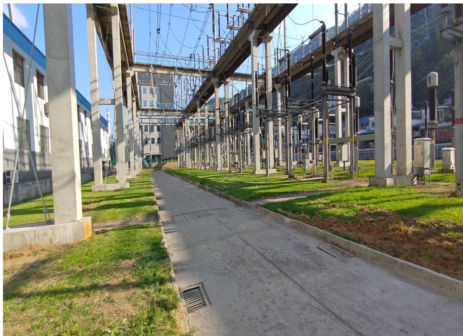
图 4-1 施工营地迹地恢复现场照片
