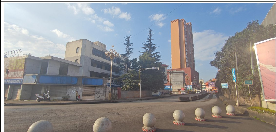
电厂西侧的周边环境
