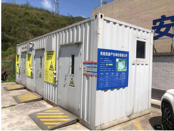
危险废物暂存间
