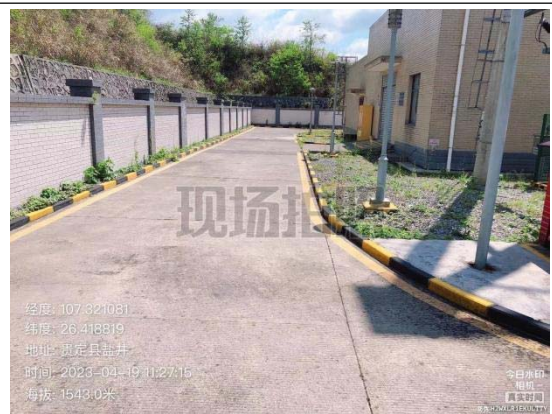
场内硬化道路
