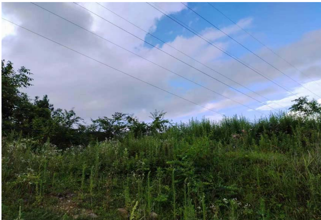
施工临时设施拆除恢复现状照片
