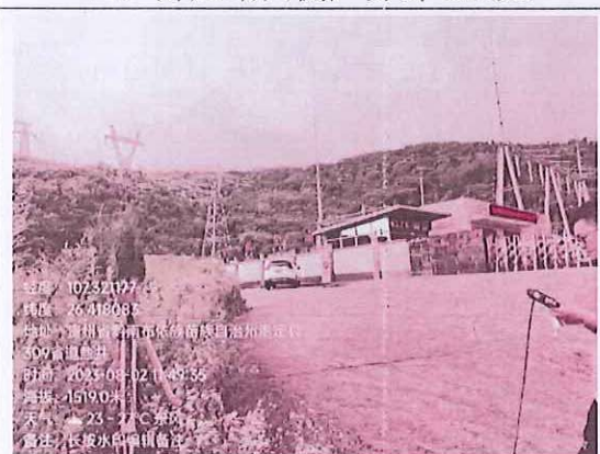
T5: 升压站南侧厂界外 10m 处
