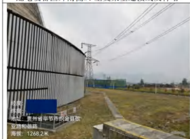
#2 主变架空连接线情况
