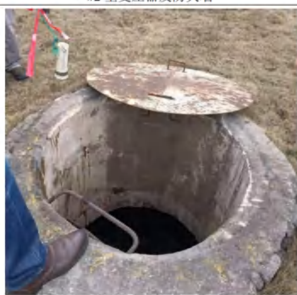
厂区事故池现状 130m 3
