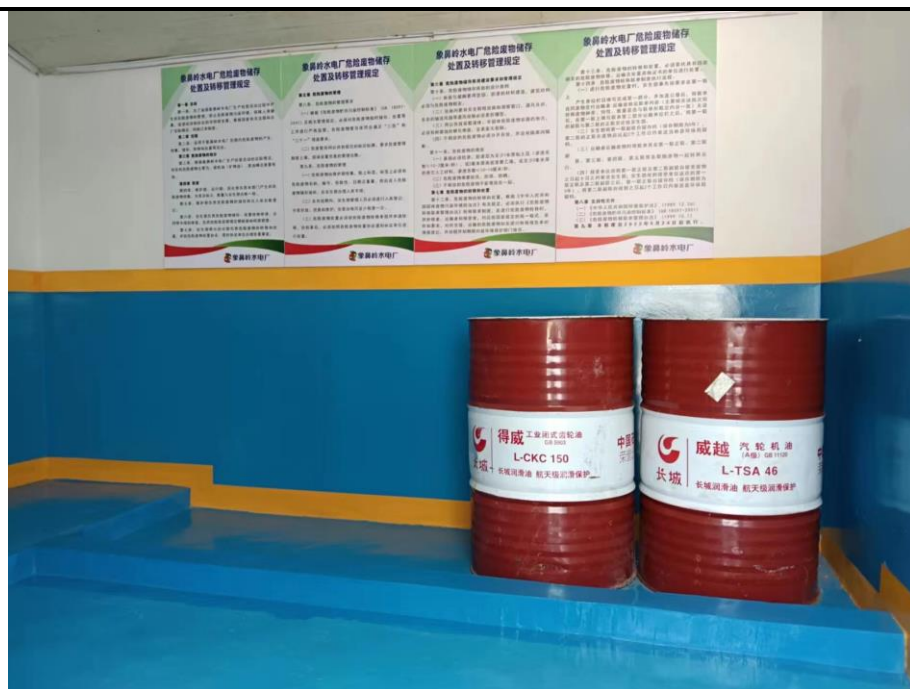
危废暂存间现状图片 2（制度已上墙，已采取防渗措施）
