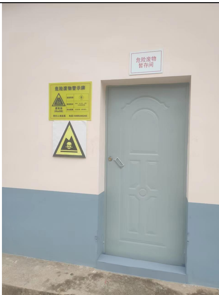
危废暂存间现状图片 1（已设置标牌标识）
