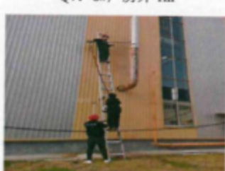
Q10: 蒸汽发生器排气筒出口
