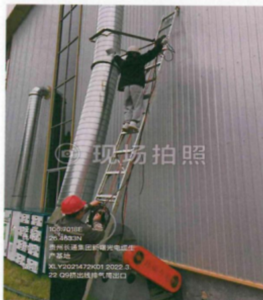
Q9: 挤出线排气筒出口
