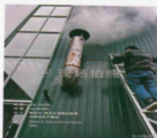
Q14: 蒸汽发生器排气筒
