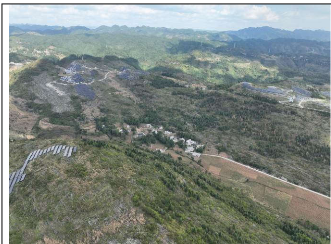
光伏区建设情况
