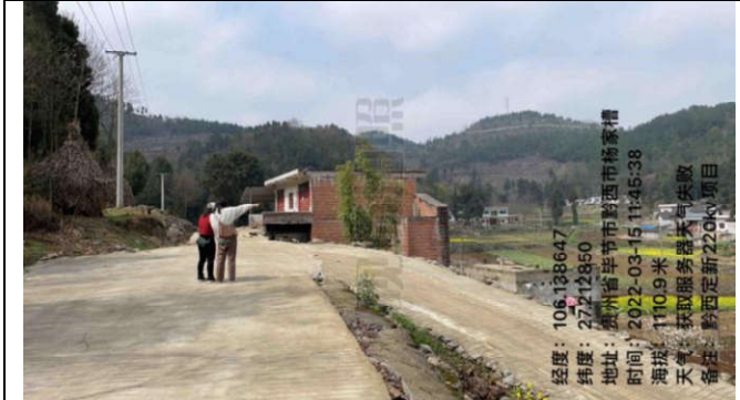
小堰居民点（塔基 P6~P7）
