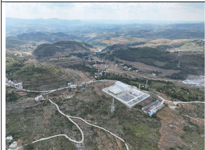
升压站周边现状
