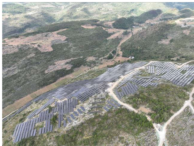
光伏区建设情况
