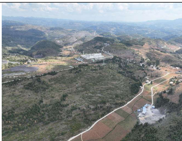
升压站周边光伏区
