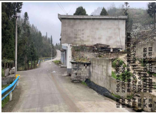
野猪窝居民点（塔基 P3~P4）
