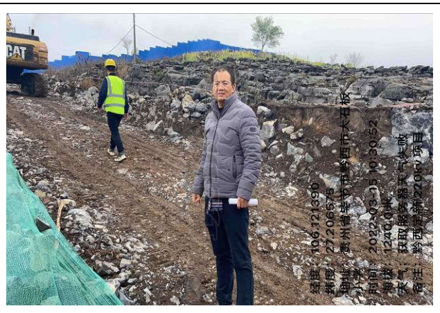
工程师现场踏勘照片
