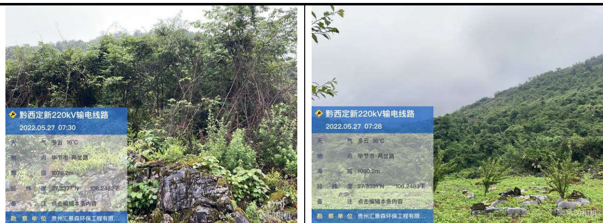
塔基 P54~55 跨越生态红线区
