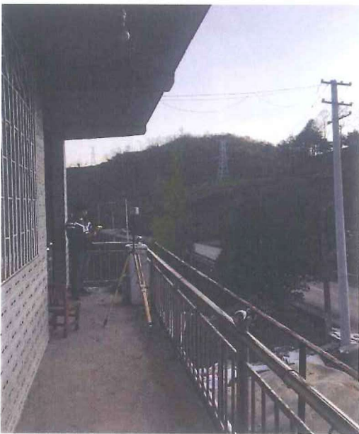
原 220kV 盖北Ⅱ回 10 # -11 # 杆塔处钟山区 三块田村三组（杨芸家一楼楼顶）
