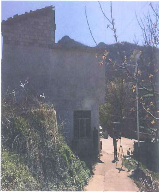
原 220kV 野北Ⅱ回 30 # -31 # 杆塔处钟山区 渔塘村二组（罗洁成家）
