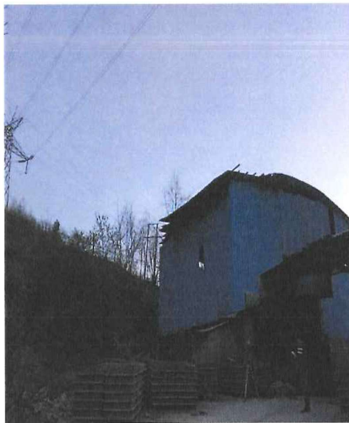
原 220kV 盖北 I 回 9 # -10 # 杆塔处钟山区 三块田村三组 (顺鑫混凝土加工厂房)
