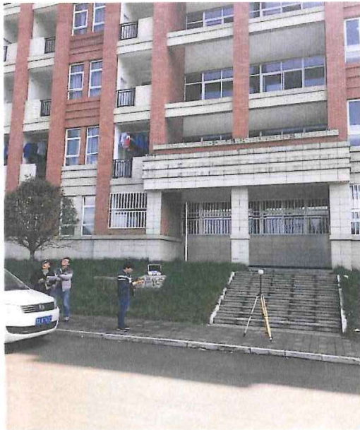
原 220kV 野水线 10 # -11 # 杆塔处 (六盘水市第十中学学生宿舍楼)
