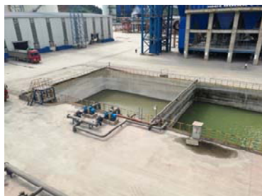
事故池及初期雨水池
